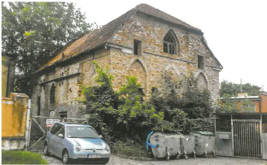
Ehemalige Synagoge in Marienwerder, dem heutigen Kwidzyn, die instand gesetzt werden soll. Einst war sie das religiöse Zentrum der Umgebung. Foto Mamlock Foundation
